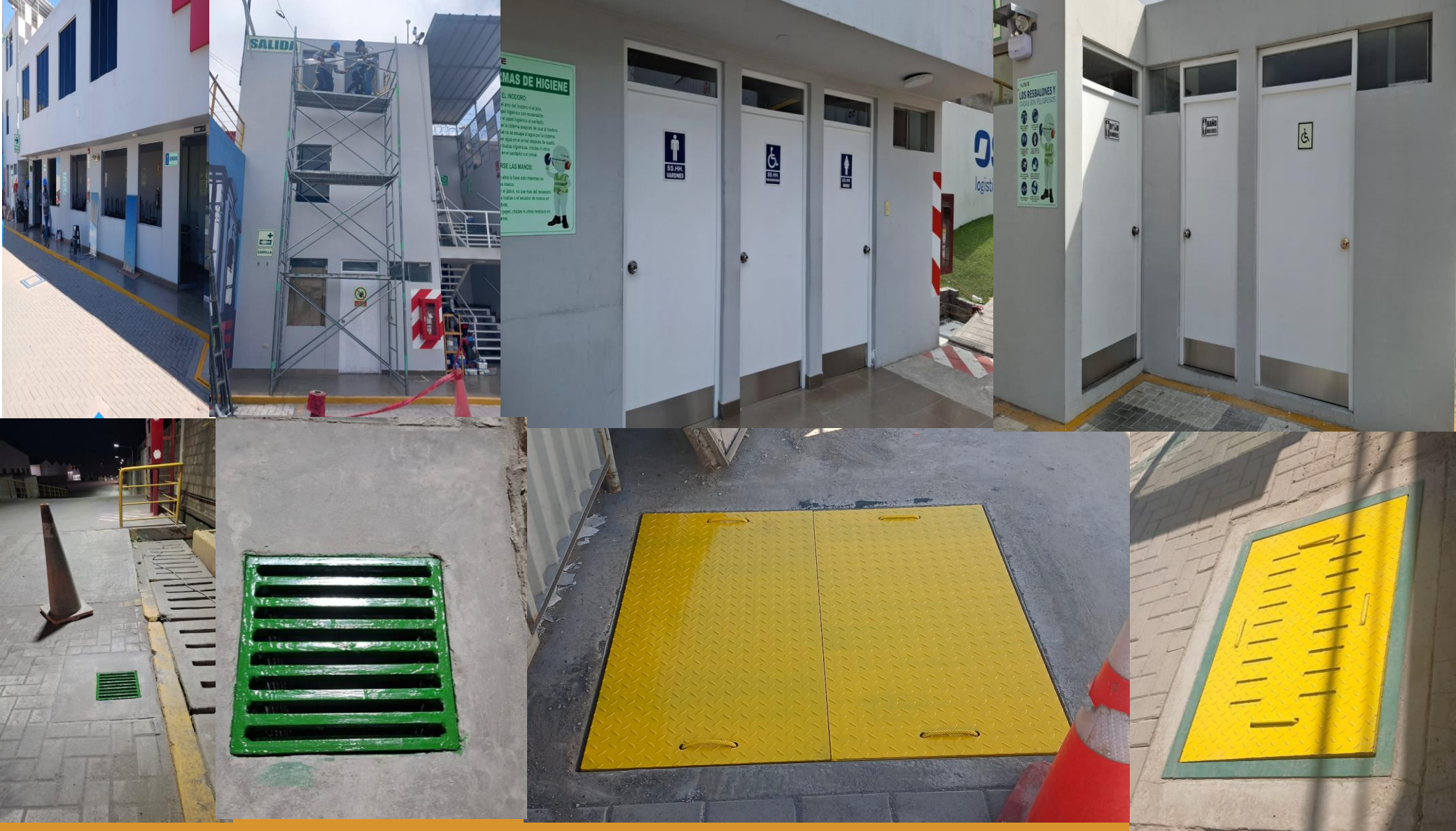
Fabricación e instalación de tapas metálicas para buzones, mantenimiento de ventanas y mamparas (Laminado y polarizado), mantenimiento de puertas de madera de Servicios Higiénicos
